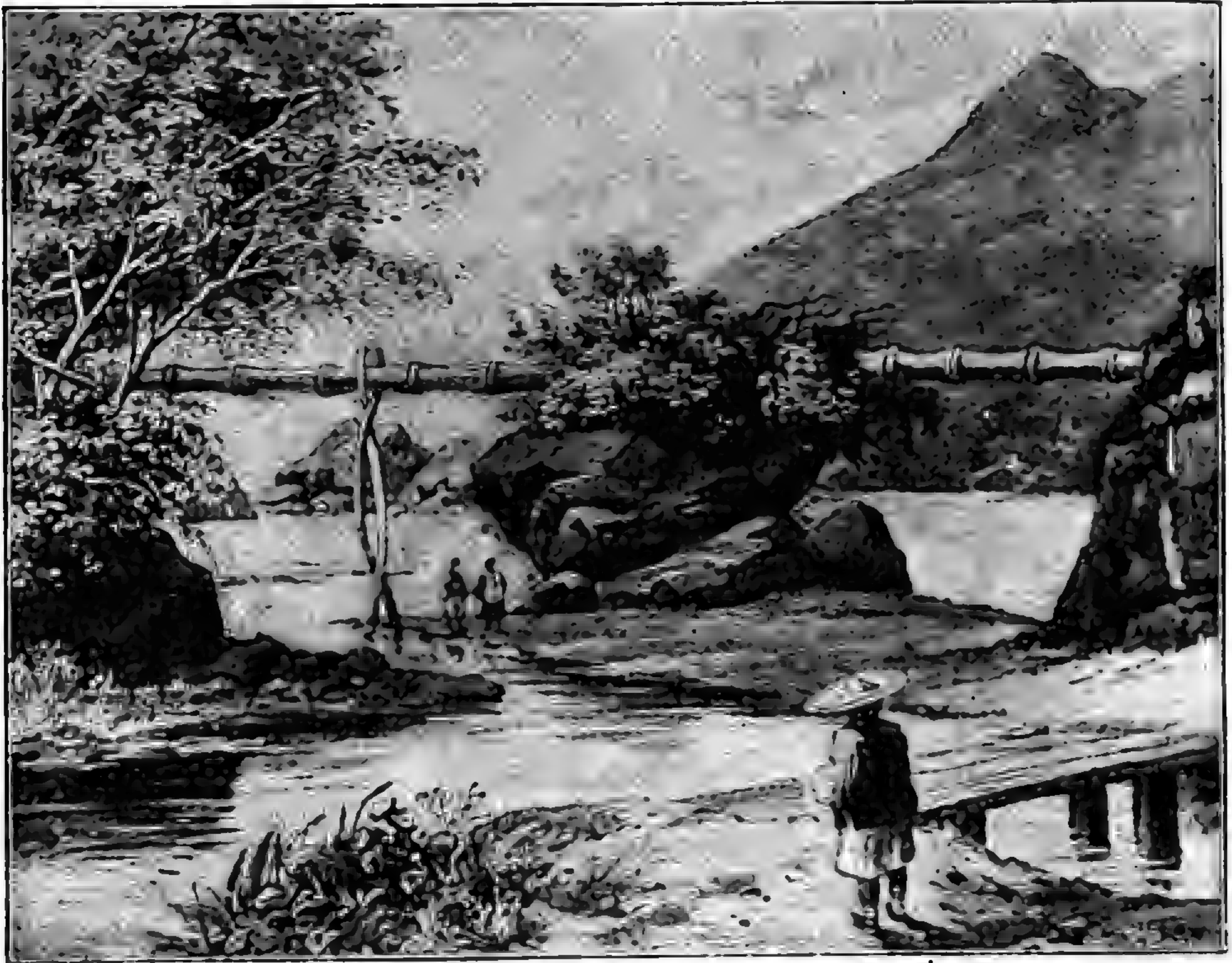
513. Водопроводъ изъ бамбука.
